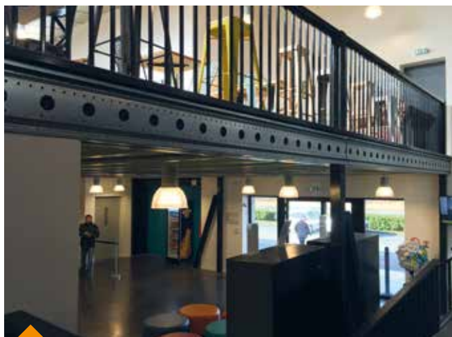
Mezzanine avec garde-corps ERP.
