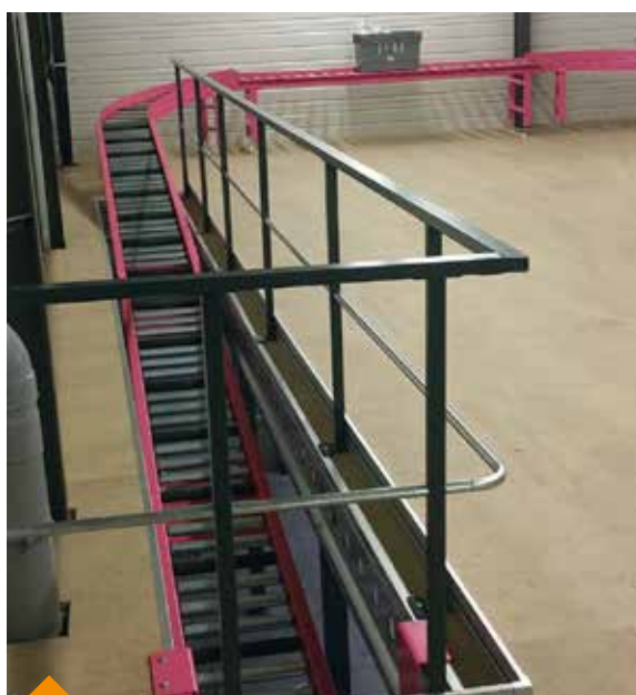
Plateforme avec intégration de convoyeur.
