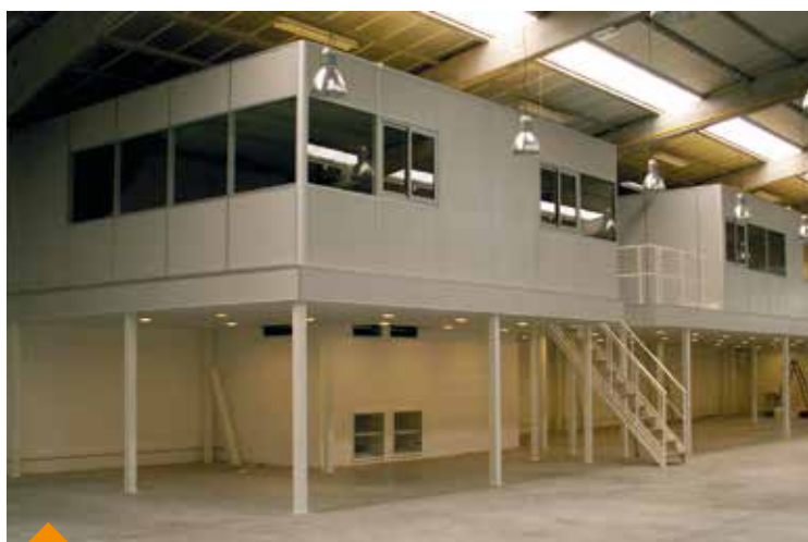
Réalisation de bureaux et salles de réunion sur plateforme.
