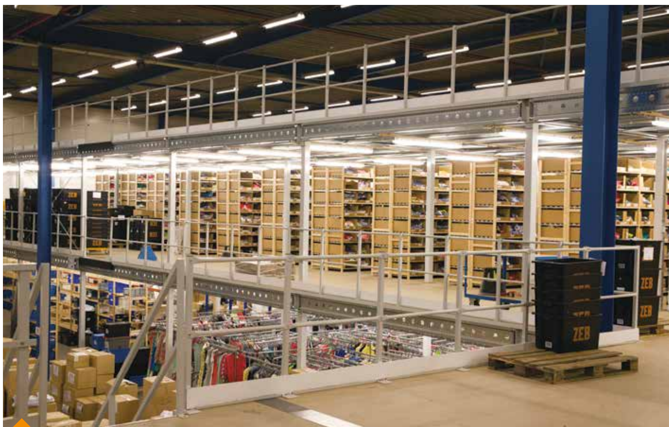
Plateforme logistique adaptée à la préparation de commandes.
