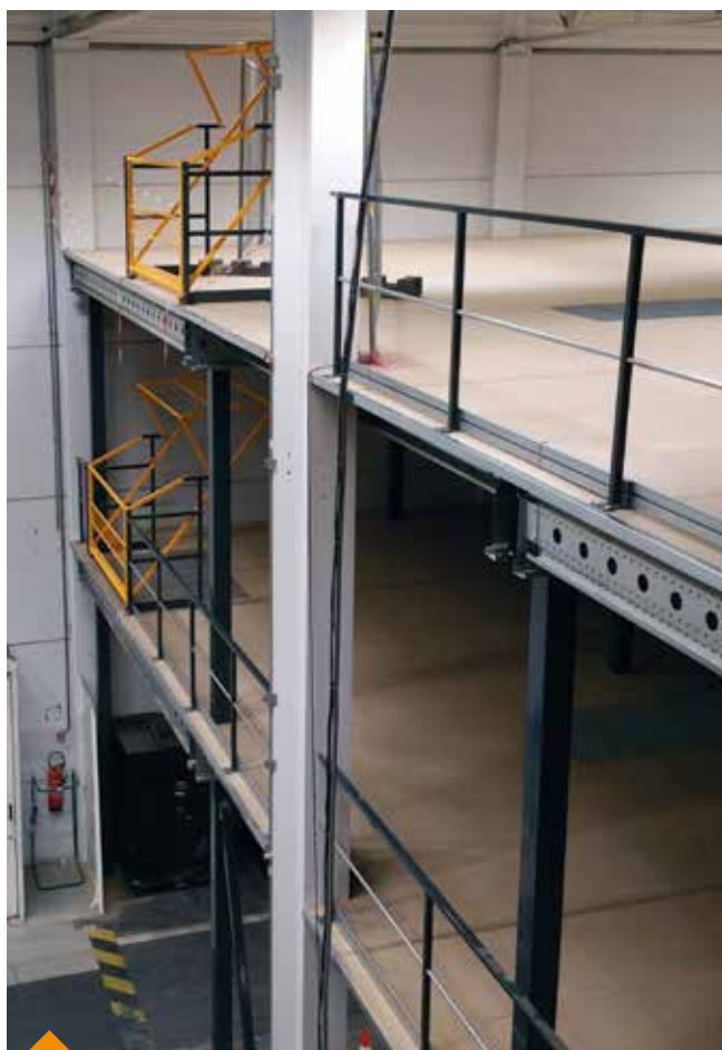
Plateforme 2 niveaux équipée de barrières écluse basculantes.
