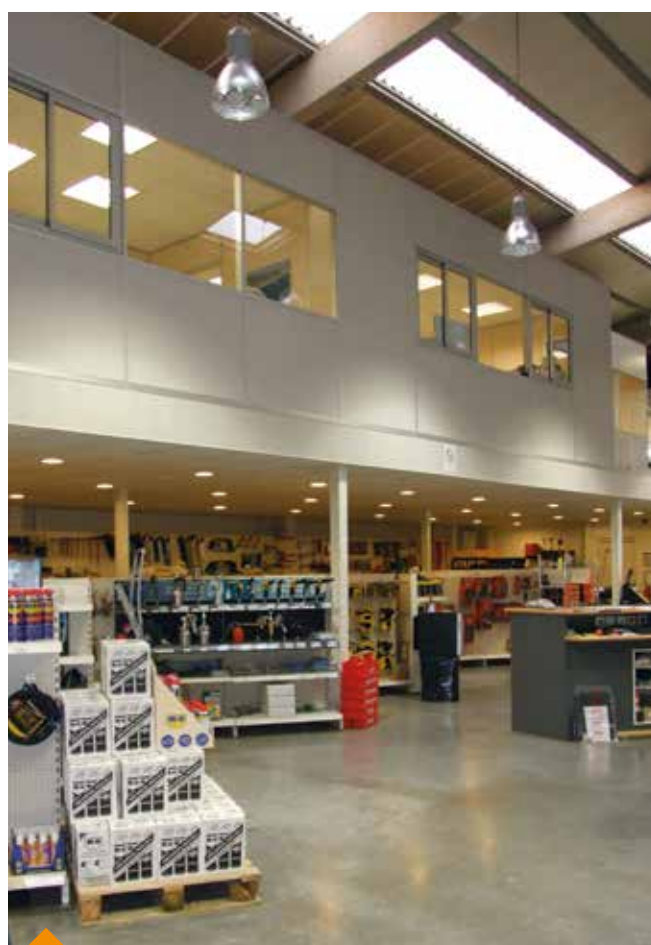
Création de bureau sur la base d'une plateforme LP3.
