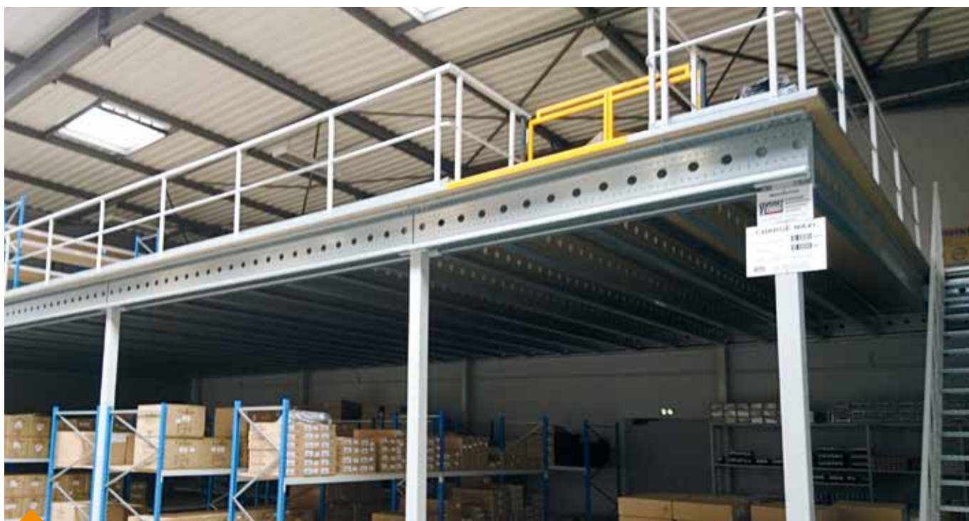
Plateforme équipée d'un portillon avec sas de dépose.
