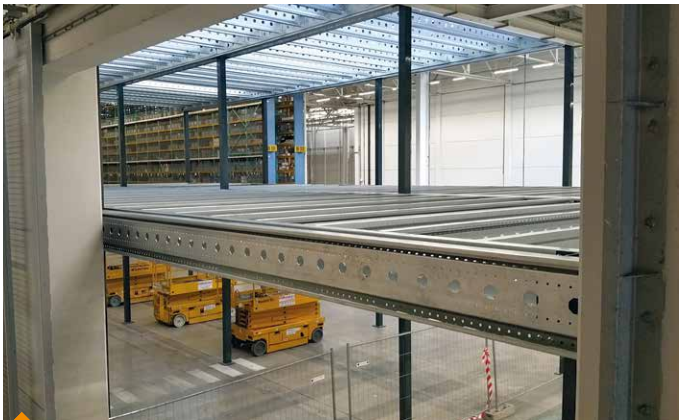
Plateforme de stockage.
