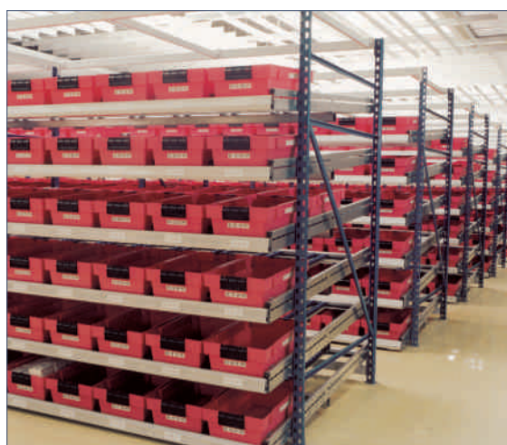
Solution réalisée pour la CERP de Rouen. PRORACK+ est équipé de cadres dynamiques inclinés pour faciliter le prélèvement des médicaments dans les bacs.
