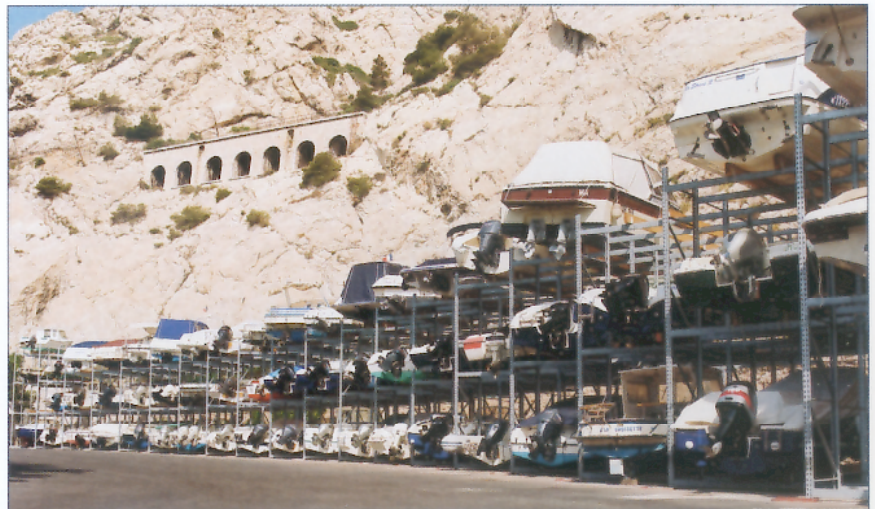
Une réalisation PROVOST de "port à sec" Marseille, L'Estaque, environ 400 emplacements.
