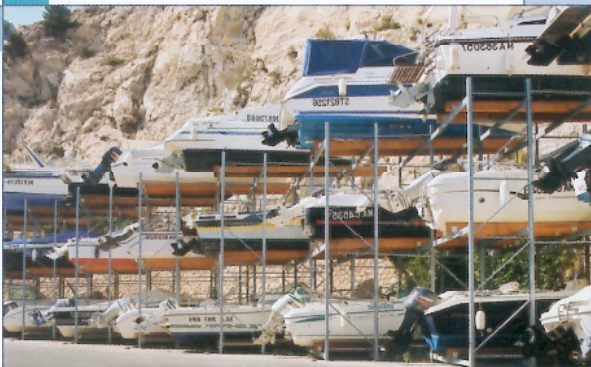
Installation en épi pour le stockage de bateaux sur terrains étroits.
